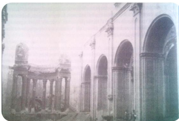
Un aspecte de la destrucció provocada a l'església de Sant Antoni
